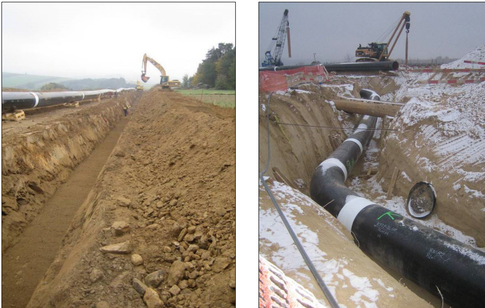
Abbildung 21 Erstellung des Rohrgrabens und Unterquerung von Fremdleitungen
