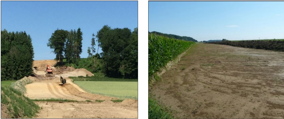
Abbildung 17 Trassenvorbereitung, Oberbodenabtrag
