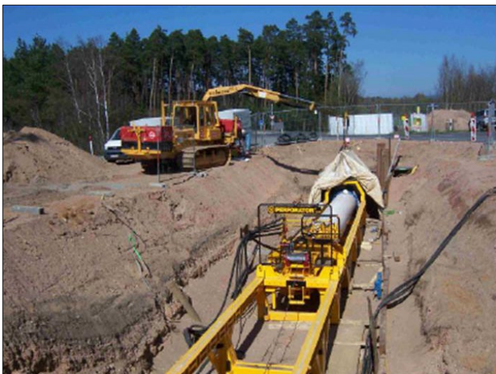
Abbildung 27 Horizontal-Bohr- / Pressverfahren
